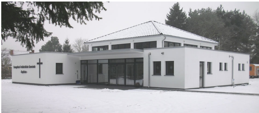
Neubau der EFG Zeesen am 15.1.2013
