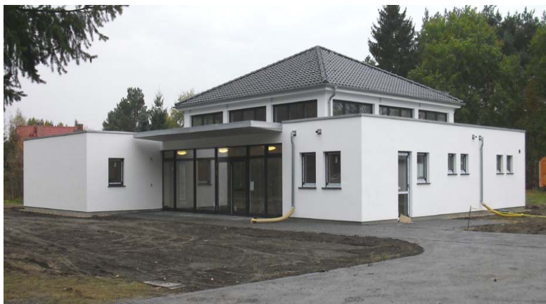
Zustand des Neubaus der EFG Zeesen am 1. November
